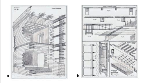
Figure 8. Gino Zani, Tavola 6 – Casa asismica; Tavola 4 - Solai, Soffitti e Scale. (LO CURZIO 1986)
