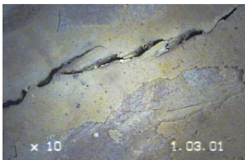
Figura 5. Crettatura nel fascione di legno, parete nord a circa 1,5 m dalla parete est: videomicroscopia ad analisi di immagine (10x).
