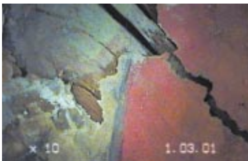
Figura 4. Posizione in corrispondenza della decorazione rossa sulla trave ovest, distacchi e lacune: videomicroscopia ad analisi di immagine (10x).
