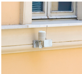
Figura 3. Posizione dei sensori a) dentro l'armadio b) dentro il deposito c) all'esterno
