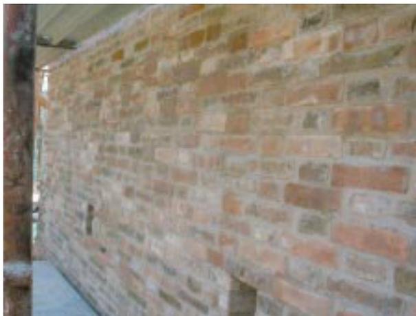
*Figura 9. Ricostruzione del rivestimento in cui si osservano mattoni nuovi e mattoni originali con presenza di licheni.*
