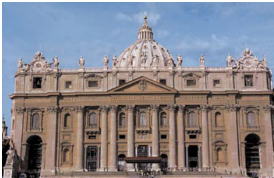
Figura 1. Facciata della Basilica di San Pietro prima del restauro.
