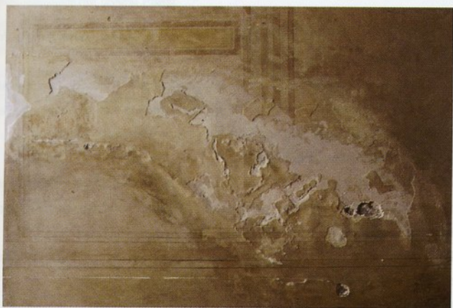
Fig. 10 - Sala di Apollo, Castel Sant'Angelo, Roma: veduta della parete Nord, particolare dell'intonaco degradato sul quale è stato effettuato nel 1967 il consolidamento con Paraloid (15).
